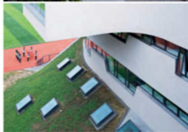
1 空中操场空中操场(摄影: 张京虎) 2 操场及步行道(摄影: 张京虎)
