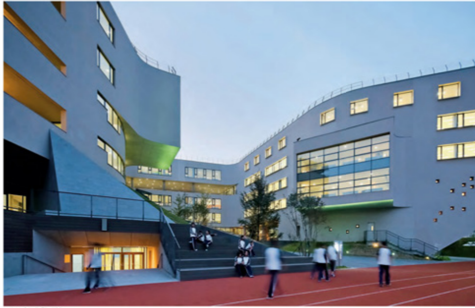
7 建筑外景 (局部)
